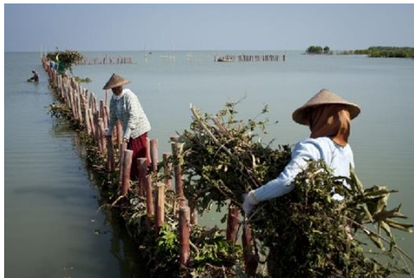
Figuur B.5 De slibremmer (Tauw) en flood protection met lokale vegetatie (Ecoshape).
