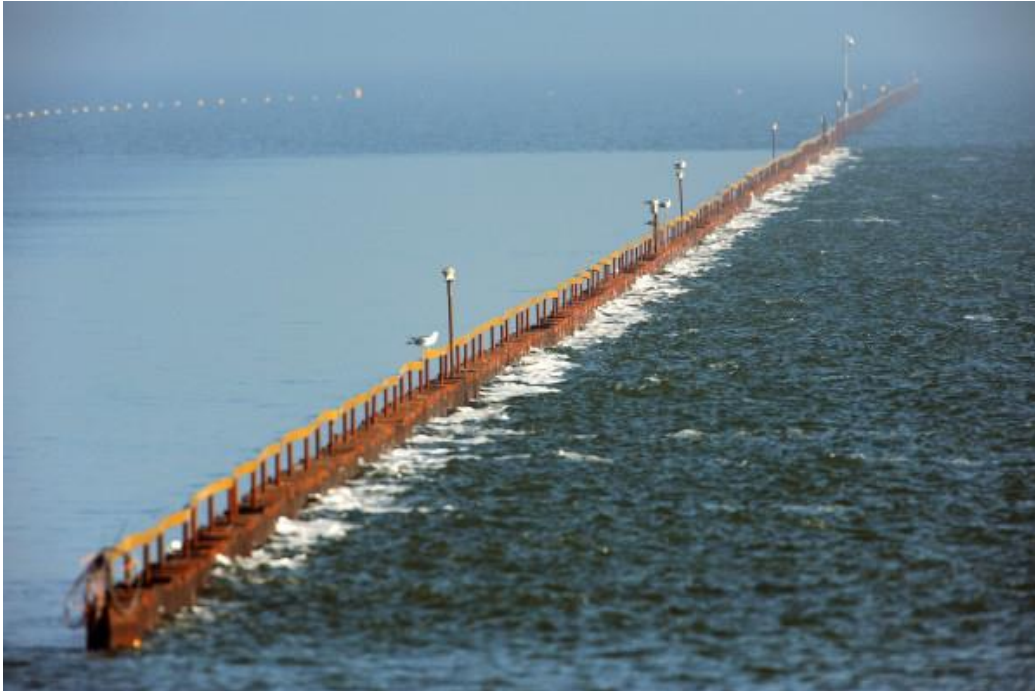
Figuur B.1 Voorbeeld van de luwtestructuur bij Warder in het Markermeer zoals tijdelijk aangelegd voor het Onderzoeksprogramma Natuurlijk(er) Markermeer-IJmeer (NMIJ) [5, 6].
