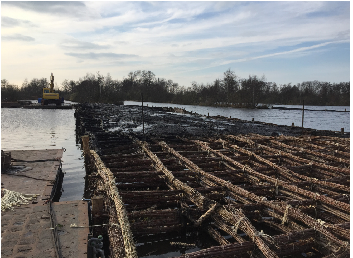
Vb. pilot voor aanleg rieteiland d.m.v. wiepen
